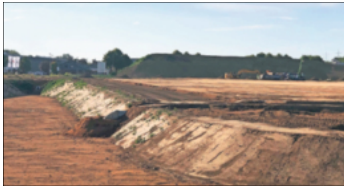
Die wochenlangen Erdverschiebungen auf dem LIDL-Gelände lassen schon heute erahnen, welche Dimensionen dieses Logistiklager annehmen wird. Jetzt wurden Abwasserkanäle verlegt, die gleich neue Sorgen bei den Nachbarn hervorgerufen haben. Foto: -gpm.
