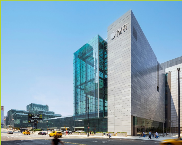
Spezielles Glas für Kollisionsschutz von Vögeln beim Javits Convention Center in New York (links) Lärmschutztunnel in Hamburg-Schnelsen zur Steigerung der Lebensqualität von Anwohnern (rechts)
