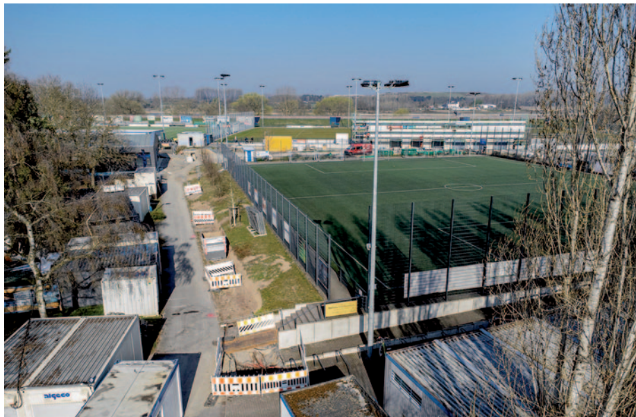
Foto: BTSC Blick auf die Großbaustelle Rheinstadion mit abgesperrten Ausschachtungen.
