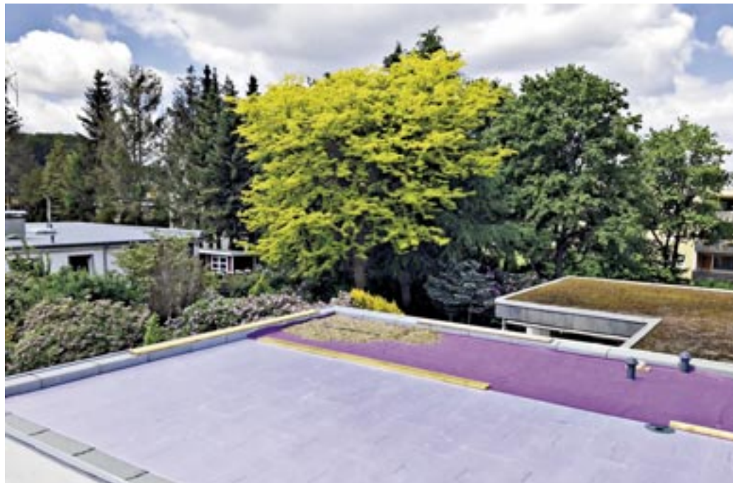
Das diffusionsoffene Dachvlies, das über der Wärmedämmung zum Einsatz kommt, wirkt lagestabilisierend und wasserableitend. Foto: Jackson Insulation GmbH Marketing
