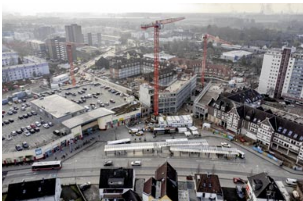
Der aktuelle Baufortschritt aus der Vogelperspektive.
