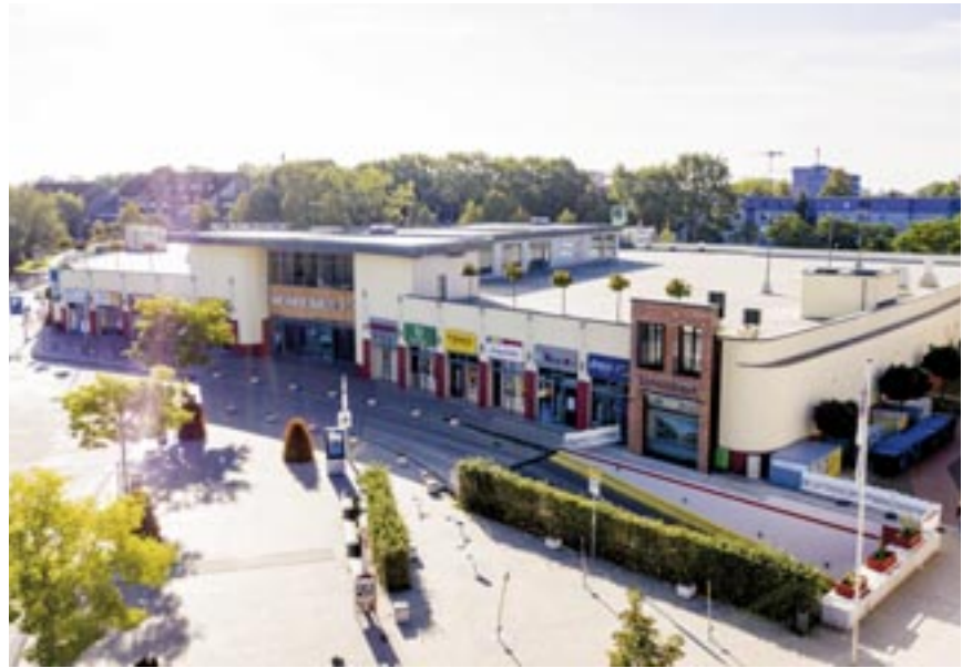
Das Monheimer Tor vor Baubeginn der neuen Mitte 2020.
