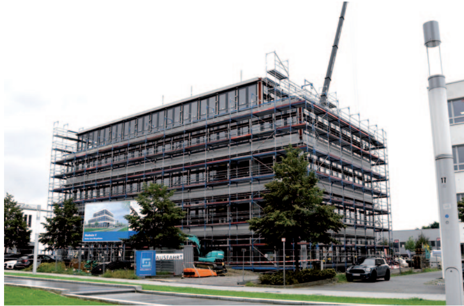
Die neue „Rheinpromenade 10“ mit sechs Geschossen und 6000 Quadratmetern Fläche baut Goldbeck in Zusammenarbeit mit Complus Real Estate direkt an der Wasserachse. Foto: Birte Hauke
