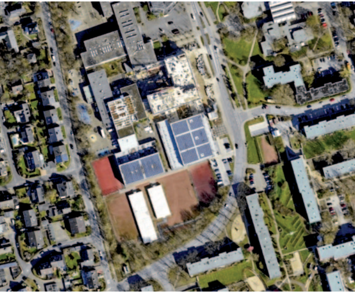
Das Schulzentrum am Berliner Ring befindet sich derzeit im Wandel. Auf dieser Ansicht ist die neue Gesamtschule noch im Bau.
