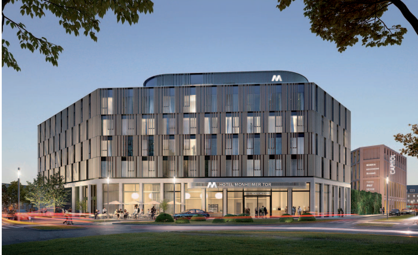
Das Monheimer Tor als prägnanter Stadteingang: Das zweite Stadthaus „Tor zur Stadt“ entsteht am neuen Kreisverkehr, der bei der Neuordnung der Verkehrsflächen am ehemaligen Platz der Lokomotive gebaut wird. In dem Gebäude ist ein Hotel vorgesehen. Terrakottalamellen und eine Fassadenbeleuchtung erzeugen zusammen mit den beleuchteten Hotelzimmern ein stimmungsvolles Lichtspiel.
