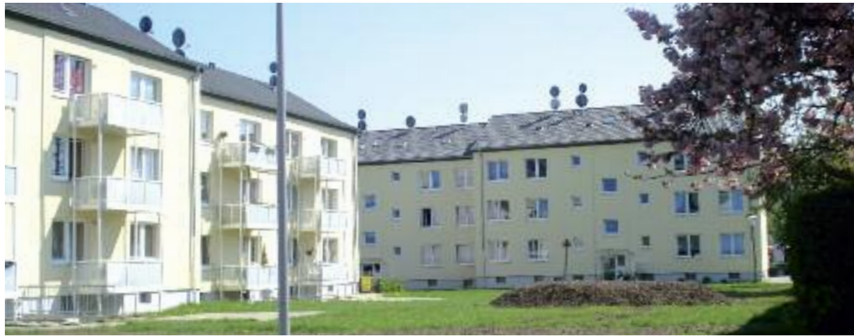
Sanierte Zeilenbebauung in Eschweiler-Ost/Renovated zeilenbau (linear housing blocks) in Eschweiler-Ost
