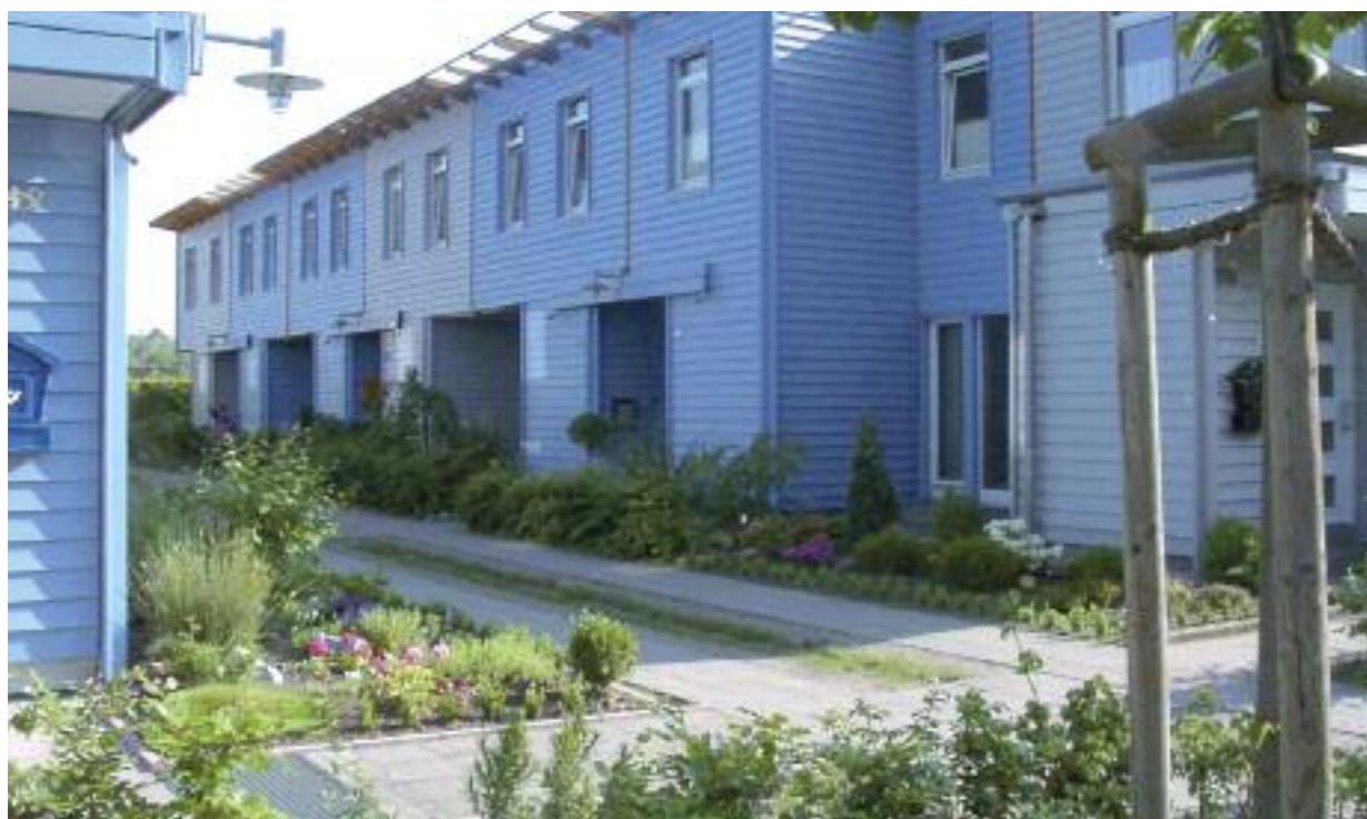
Schaffung neuer Wohnangebote im Quartier – Siedlung „Einfach und selber bauen“ in Gelsenkirchen-Bismarck/Schalke-Nord Creation of new housing in the neighbourhood – the “Einfach und selber bauen” (“Build it yourself”) residential estate in Gelsenkirchen-Bismarck/Schalke-Nord
