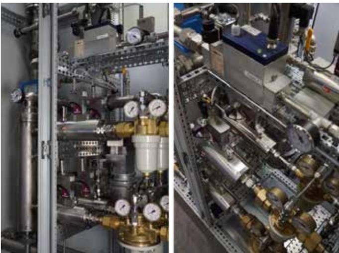
**Abbildung 22:** Innenansicht der großen Gasmischanlage, bis zu 1 MW Brennerleistung sind reine Wasserstoffversuche möglich (Quelle: GWI)
