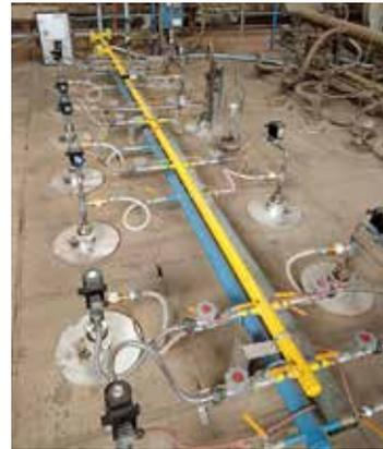
b) Umgebaute Brennerreihe in der Tunnelofenanlage in Bellenberg (Quelle: Bellenberg)
