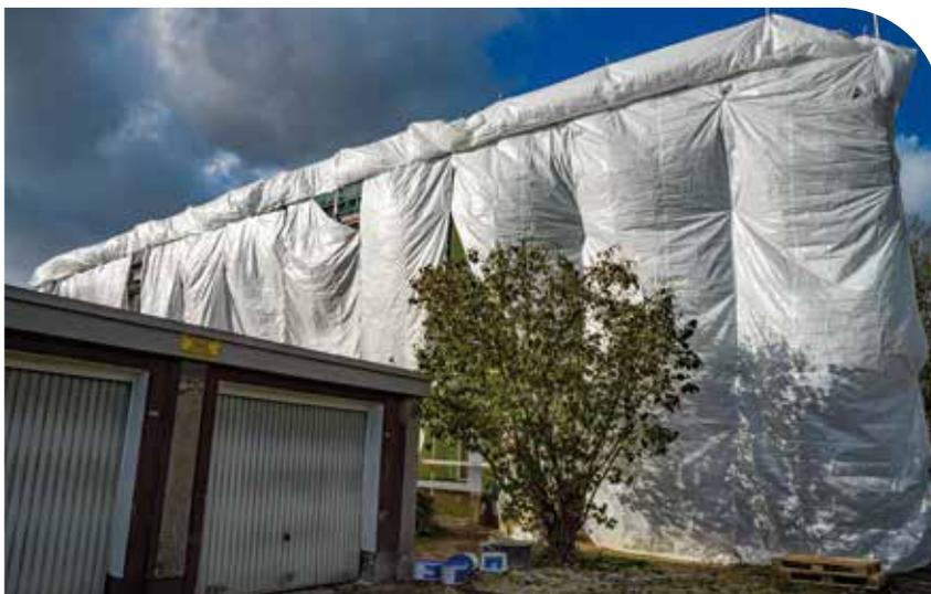
gangsbereiche mit einem frischen Frühlingsgrün – der WoGe Farbe – Akzente setzen. Doch hier wurde nicht einfach nur Farbe aufgetragen. Vielmehr wurde die gesamte Fassade mit Mineralwollplatten komplett gedämmt. Die Dachwärmeeisolation
