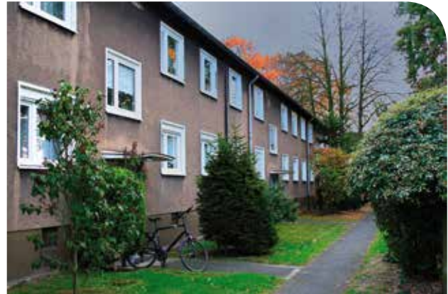
Die WoGe Ruhrgebietssiedlung an der Oldenburger Straße in Röttgersbach wird seit Beginn der laufenden Heizperiode mit Fernwärme aus dem Verbund „Fernwärmeschiene Niederrhein“ versorgt.
