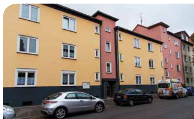
Und nicht nur das Bad der Müllers ist frisch renoviert. Vor rund vier Jahren wurden auch die Fassaden der WoGe Ruhrgebiet Häuser erneuert und mit den typischen Farben der WoGe Ruhrgebiet gestaltet.
