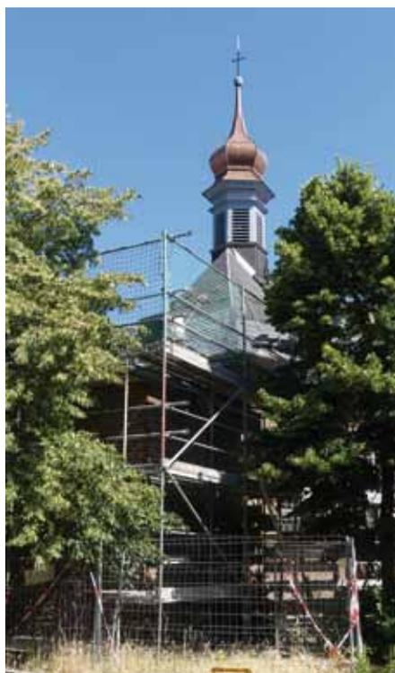
tigt beziehungsweise ausgetauscht. Im Anschluss wurden die Dachflächen in altdeutscher Schieferdeckung neu eingedeckt. Auch der Dachreiter (kleiner Glockenturm) wurde saniert.
