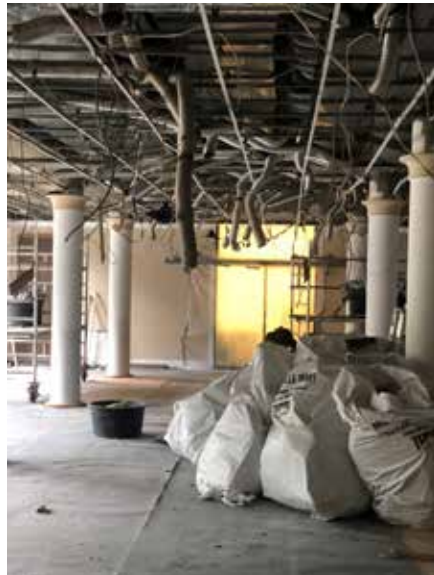
Das Restaurant ist vorübergehend eine Baustelle.
