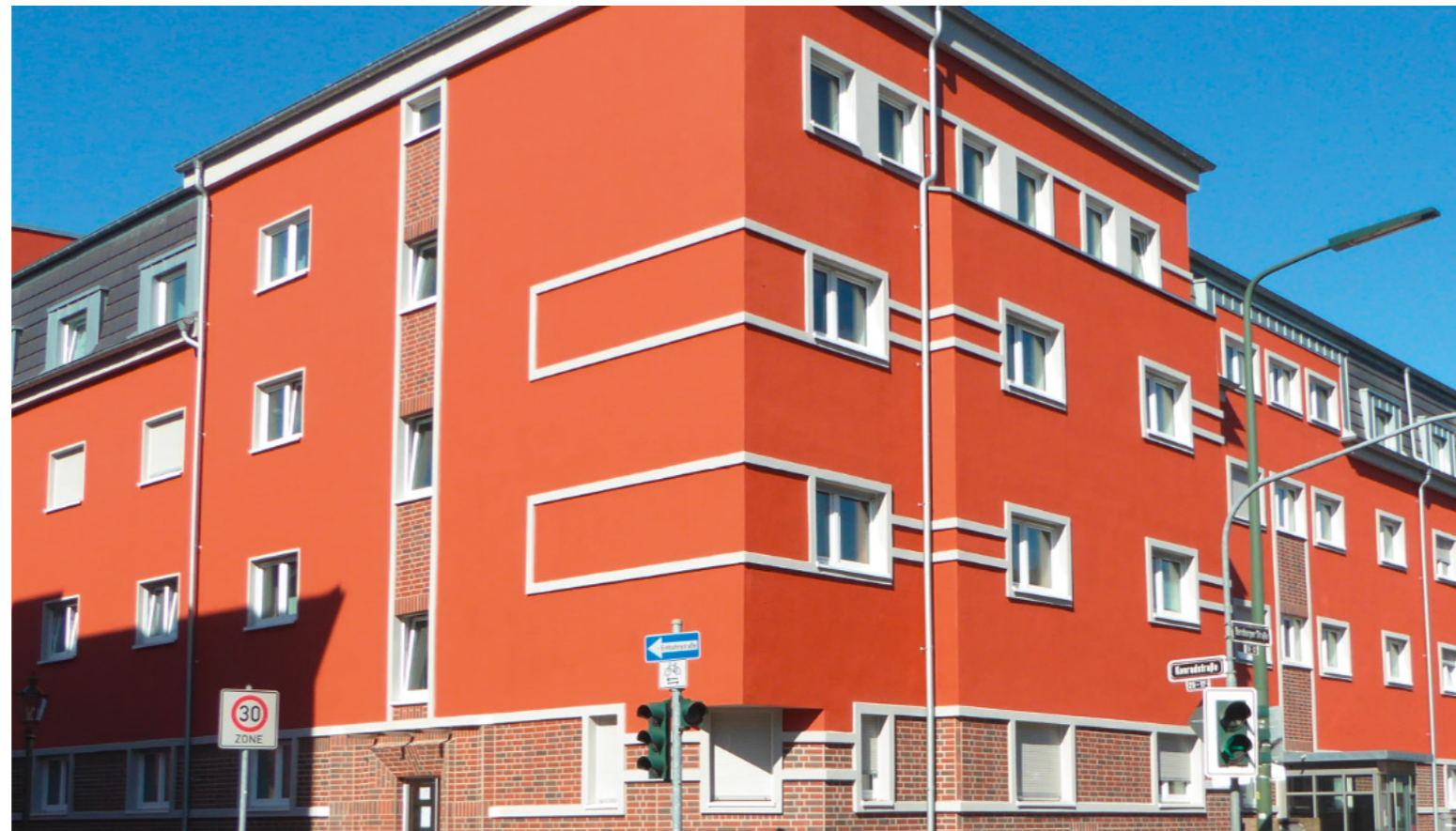
Wie früher, aber ganz anders – die neue Fassade
