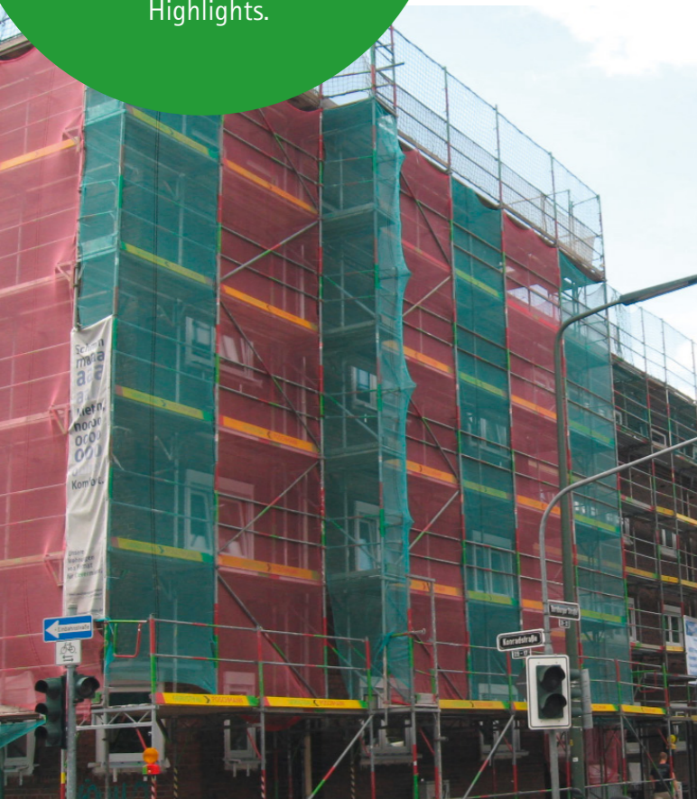
Gerüstet für die nächsten Arbeitsschritte
