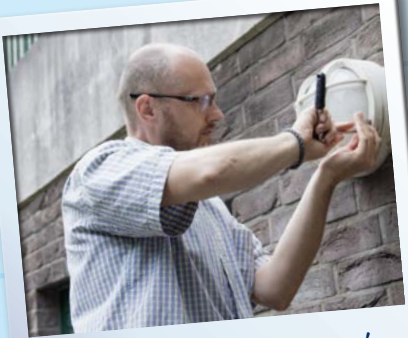
9.15 Uhr Reparatur am Bestand
