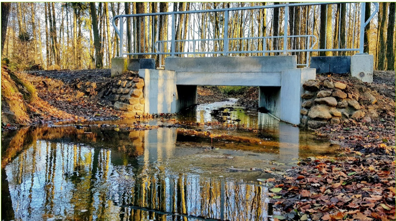
Abbildung 25: Neubau einer Brücke als Ersatz eines engen Durchlasses des Wambaches als Maßnahme zur Förderung der Durchgängigkeit von Makrozoobenthos und Fischen in Mülheim-Saarn (Foto: Renate Fuchs 2021).
