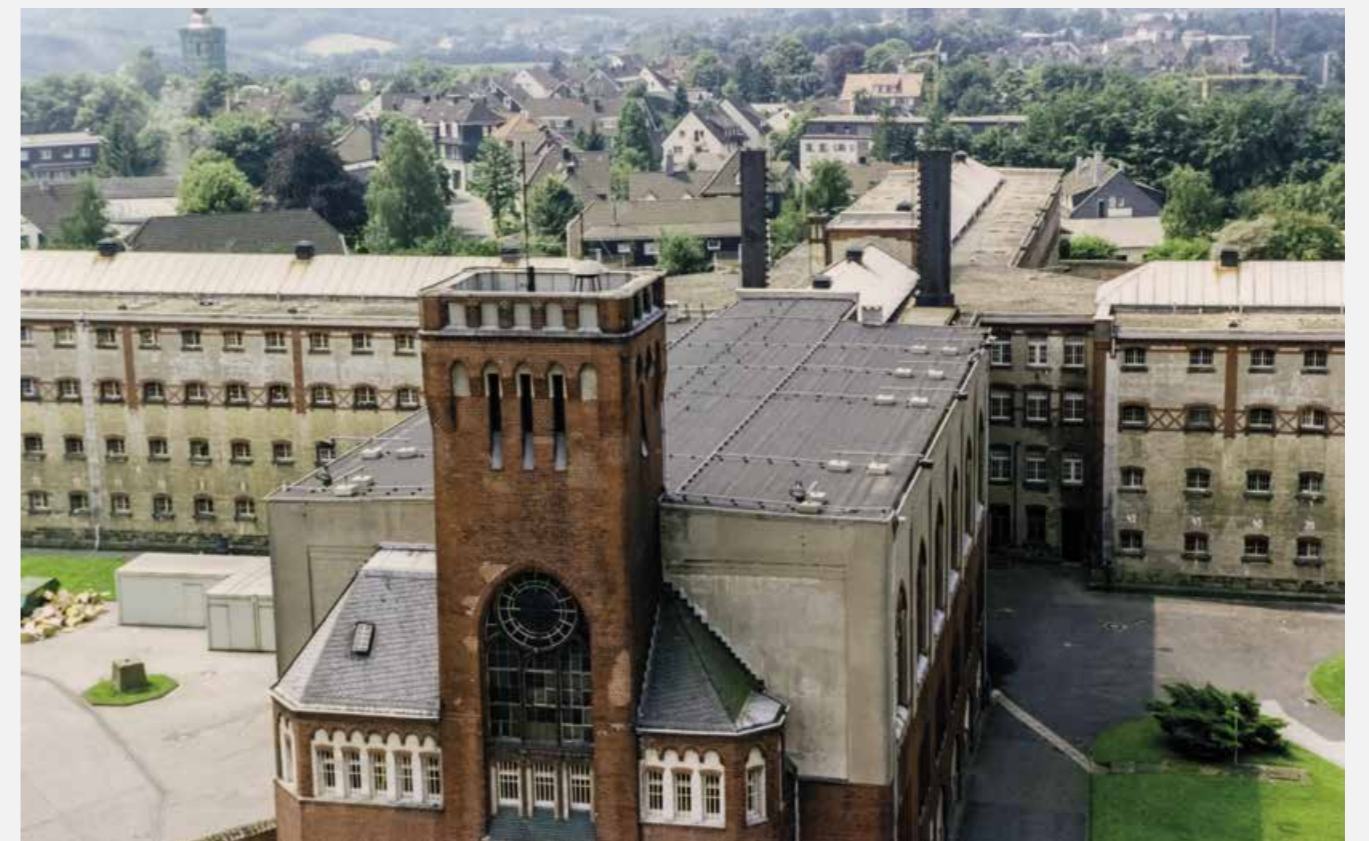
Blick vom Baukran auf die Justizvollzugsanstalt Remscheid 1992, LAV NRW R RWB 33915/2, Foto: Hans Freitag
