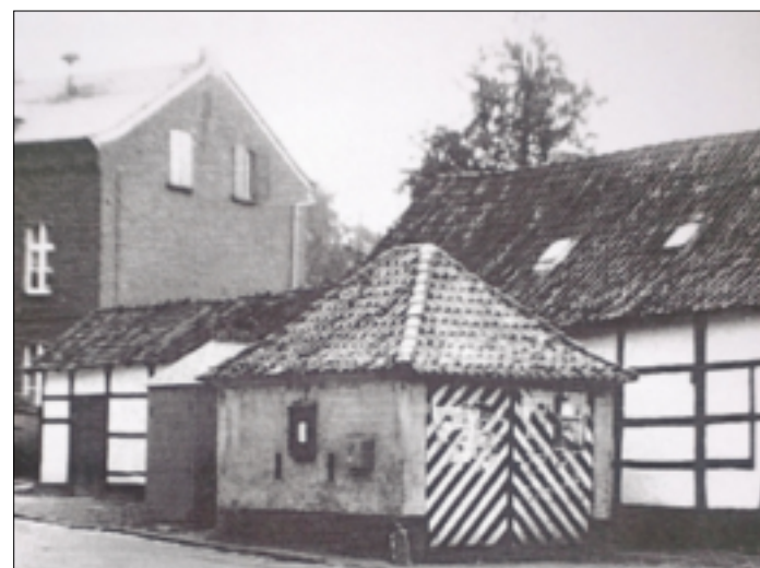
Das alte Kelzenberger Spritzenhaus an der Straßenkreuzung Im Kamp / Keltenstraße wurde am 5. Februar 1968 abgerissen, nachdem das neue Gerätehaus fertiggestellt wurde.
