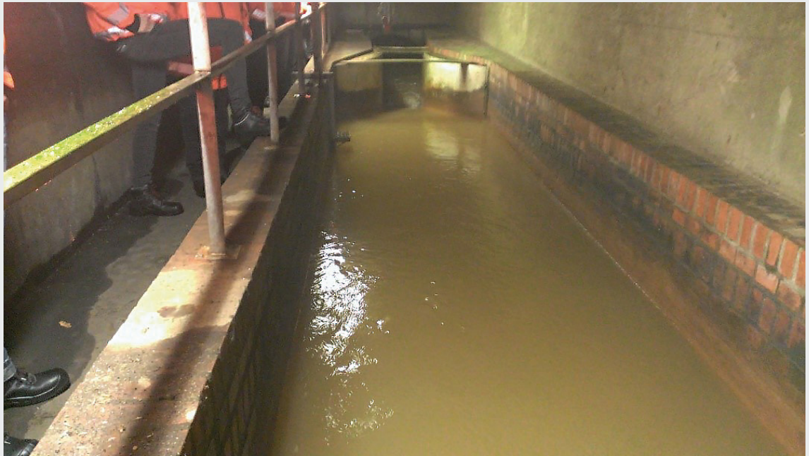
Abb. 4: Entwässerung des Westfeldes über den Dickenberger Förderstollen
