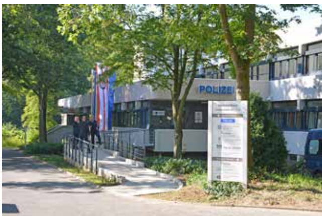
Wache Erkrath, Sedentaler Straße 110 Foto: Pressestelle
