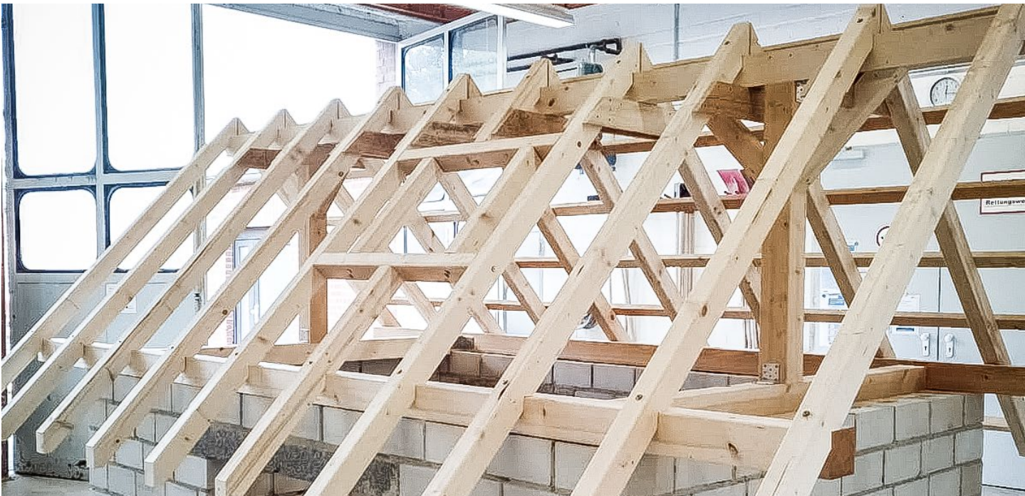
Foto aus dem Ferienkurs „Build to future: Bau eines energiefreundlichen Hauses“. Aufgenommen beim und in Abstimmung mit dem Bildungsträger „Handwerks-Bildungsstätten e.V.“ aus dem Kreis Coesfeld
