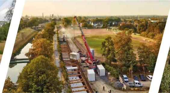
Verlegung des Abwasserkanals Emscher in Oberhausen
