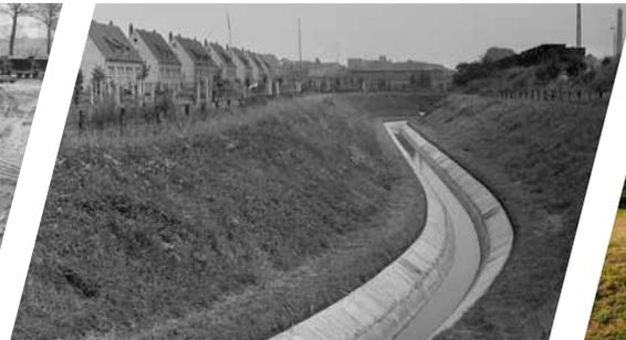
Offene Schmutzwasserläufe mit Betonkorsett
