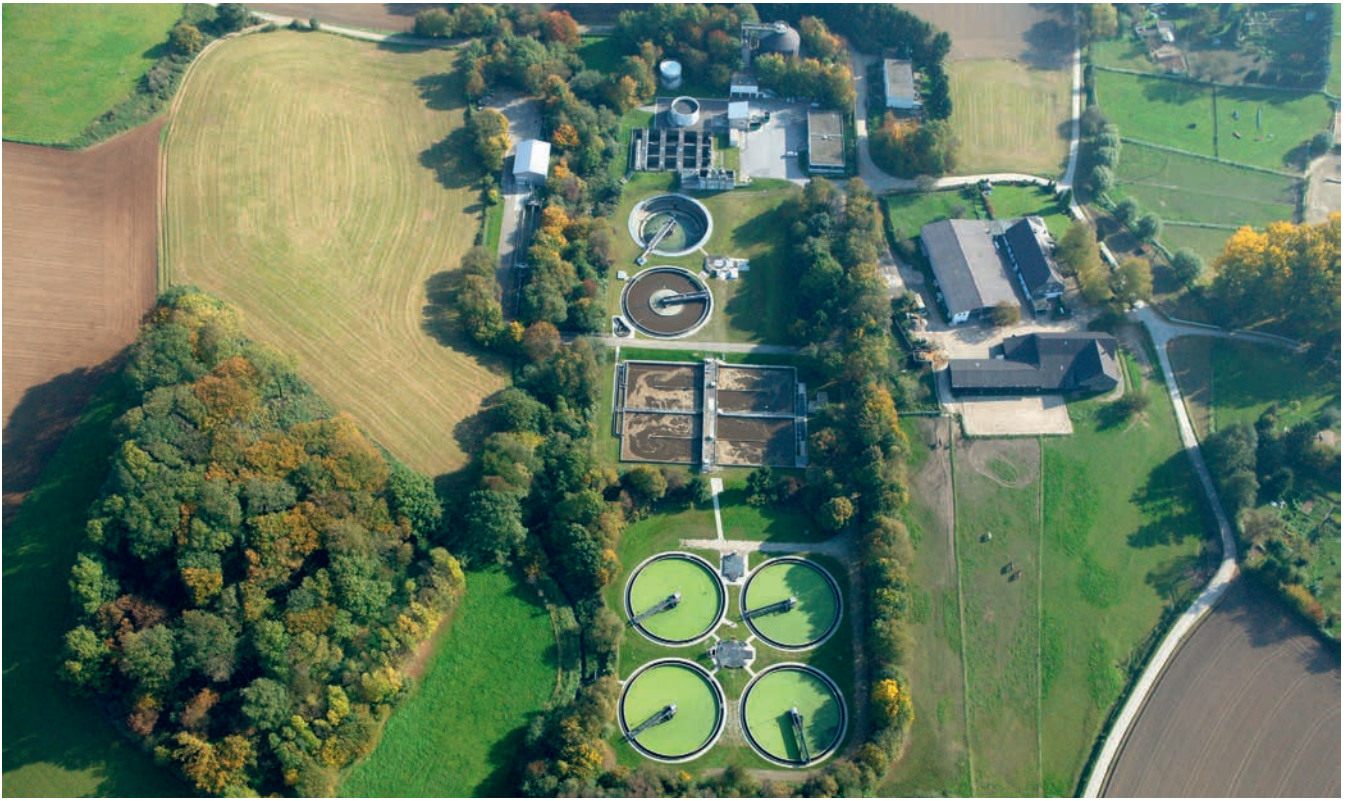
Die Kläranlage Abtsküche (oben) soll stillgelegt und das Abwasser auf der Kläranlage Essen-Kettwig mitbehandelt werden. Die liegenschaftsrechtlichen Verhandlungen sind weitgehend abgeschlossen.
