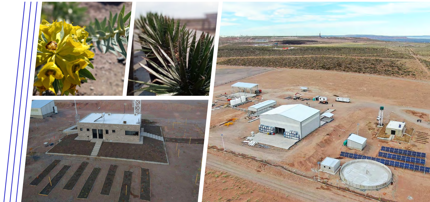
Von der Planung über den Bau bis zur Inbetriebnahme und dem laufenden Geschäftsbetrieb: In Añelo bleibt nichts dem Zufall überlassen – unabdingbar sind vorausschauendes Handeln und tägliche Aufmerksamkeit.
