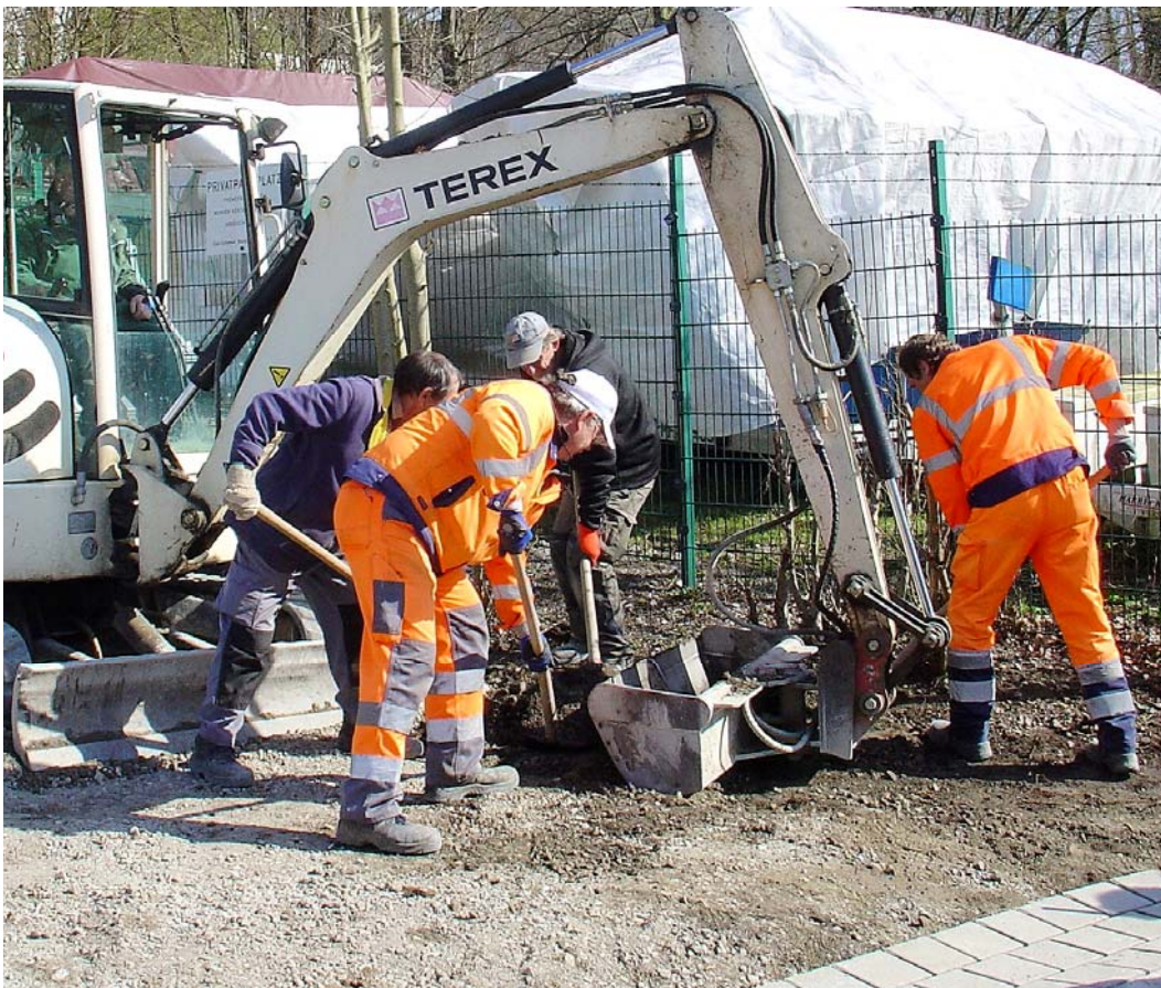
Arbeiten an der Lanfermannfähre Foto: Arbeit & Bildung Essen (ABEG)
