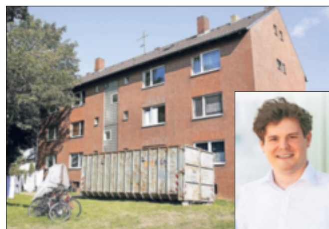
Stadtsprecher Lukas Maaßen (rechts) informiert zum Wohnheim-Neubau in Noithausen. Fotos: Staniek; Archiv; SGV
