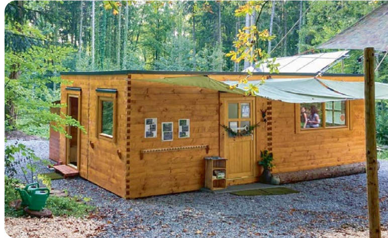
Ein Waldkindergarten in Modulbauweise: Zum Projektende sind Module für individuelle Wohngebäude und Büros geplant.
