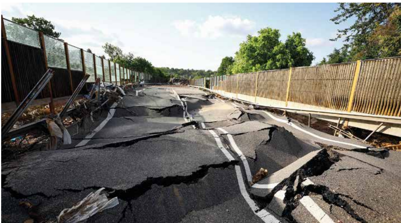
Eine zerstörte Straße in Euskirchen—Aufnahme vom 18. Juli 2021.
