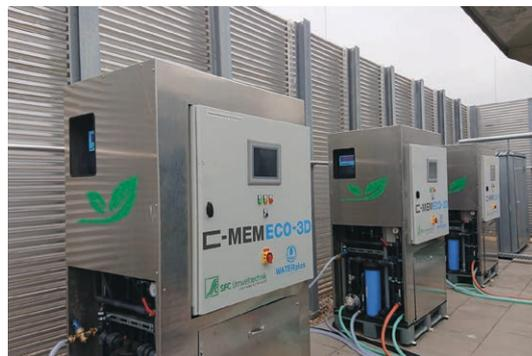
Testbetrieb der Ultrafiltrationsanlagen
