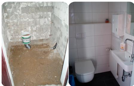
Der Betonunterbau des Fußbodens im WC hinter der Sakristei musste nach dem Entfernen der alten Bodenfliesen herausgestemmt werden. Darunter lagen völlig zerfallene Eichenbalken, die ebenfalls entfernt werden mussten. Der Bodenbereich wurde isoliert und neu gegossen.
