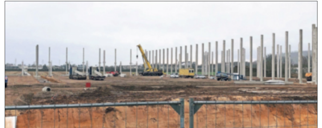
Die „Pfeiler-Galerie“ für das neue Hochlager der Chips-Fabrik lässt inzwischen ganz gut die Dimensionen des Neubaus erahnen. Fotos: -gpm.
