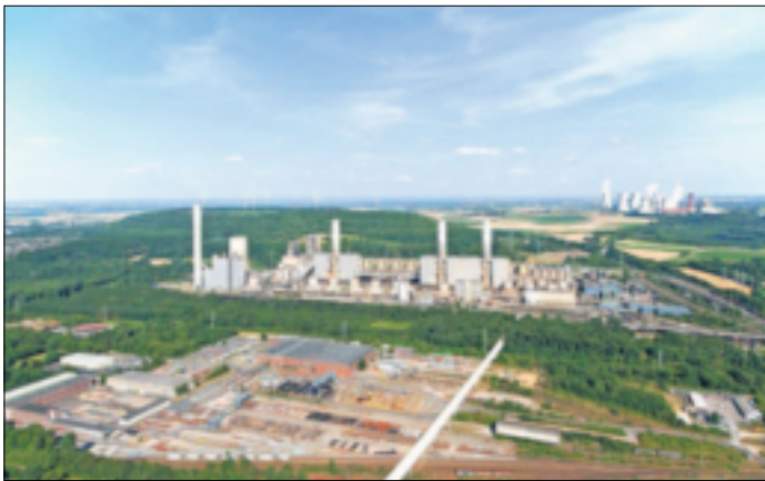
Das RWE hat das Kraftwerk Frimmersdorf endgültig stillgelegt. Die Sicherheitsbereitschaft der beiden letzten 300-Megawatt-Blöcke P und Q endete am 30. September. Die übrigen Blöcke sind schon deutlich früher vom Netz gegangen. Foto: RWE.
