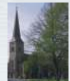
Kirche St. Georg in Heisingen Heisinger Str. 478 45259 Essen
