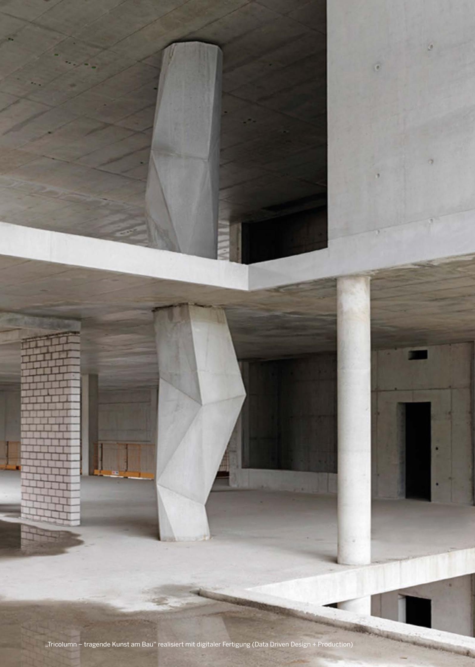
„Tricolumn – tragende Kunst am Bau“ realisiert mit digitaler Fertigung (Data Driven Design + Production)
