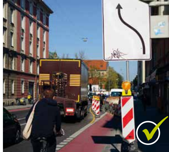
Bild 15 | Arbeitsstelle auf Radfahrstreifen durch Abspernung gesichert
