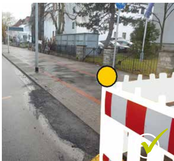
Bild 7 | Anrampung in Form von Asphaltkeil hergestellt
