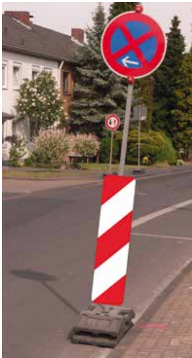
Bild 11 | Soweit die Breite für Geh- oder Radweg im Seitenraum nicht ausreichend ist, können Schilder im Einzelfall am rechten Rand der Fahrbahn aufgestellt werden. Eine Absicherung durch eine Bake ist erforderlich.
