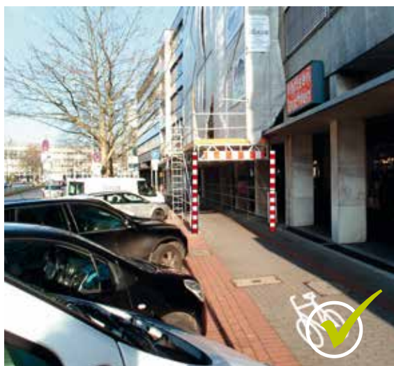
Bild 13 | Gerüst ausreichend gesichert (Anmerkung: Gehweg befindet sich unter den Arkaden)
