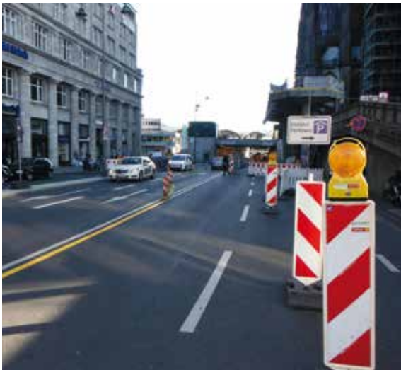
Bild 8 | Führung des Radverkehrs entlang Arbeitsstelle im Mischverkehr bei hoher Kfz-Belastung
