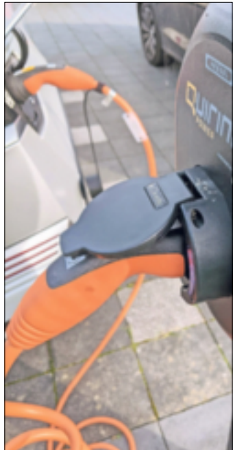
Die Stadt Bedburg plant weitere Ladestationen für Elektrofahrzeuge im Stadtgebiet. Neben Ökostrom- und Gastarifen werden die die Stadtwerke auch umfassende Beratungen und Angebote für Photovoltaik-Anlagen, Speichersysteme und Mobilitätslösungen anbieten. Foto: Privat.
