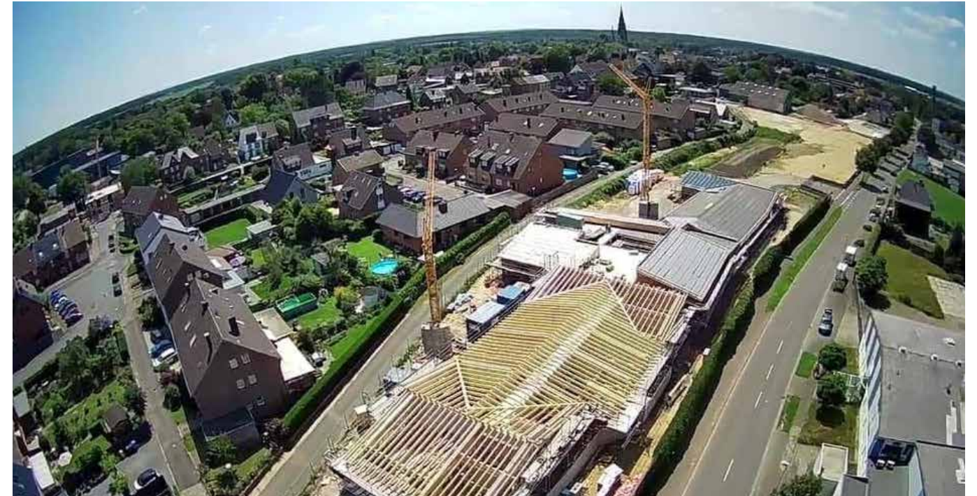
Foto des Bauunternehmers (Dachstuhl noch nicht gedeckt ist der Bereich der KiTa HPZ)
