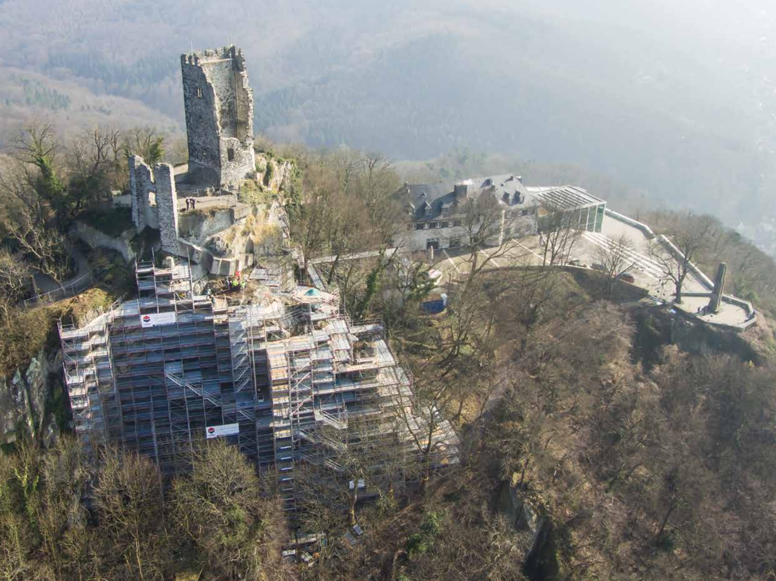
Sanierung Drachenfels, Königswinter
