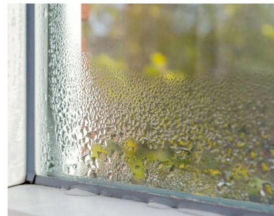
Feuchtigkeit in der Wohnung und als Ergebnis ein erhöhter Energiebedarf: Ein Austausch alter Dichtungsprofile ist dann oftmals unerlässlich.
