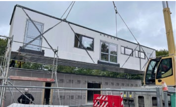
Aus der Luft schwebten die neuen Module für den Kita-Bau ein. Foto: Stadtparkasse RS
