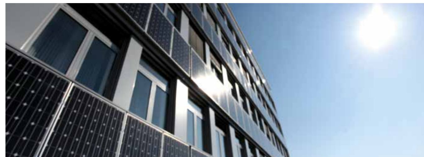
Seit 2008: eine der größten Photovoltaikanlagen in Bielefeld – knapp 600 Quadratmeter – am Franziskus Hospital Bielefeld an der Süd- und der Westfassade sowie auf dem begrünten Dach
