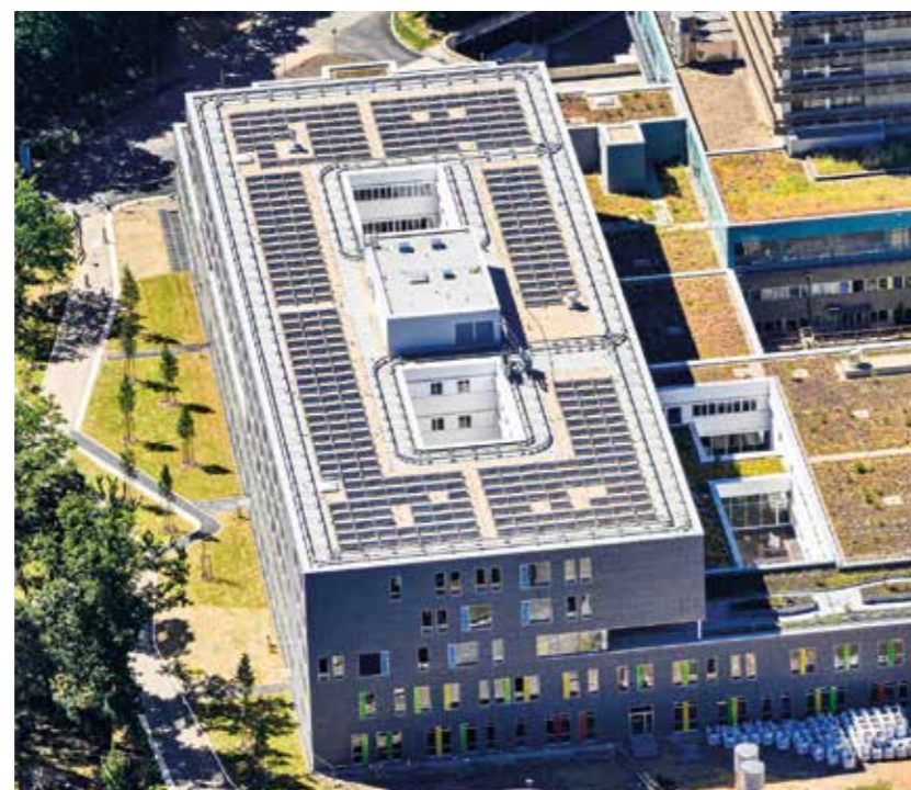
Auf dem Dach des Gebäudes der Neurologie, Psychiatrie und Psychosomatik (NPP) am Universitätsklinikum Bonn wurde eine Photovoltaikanlage installiert
