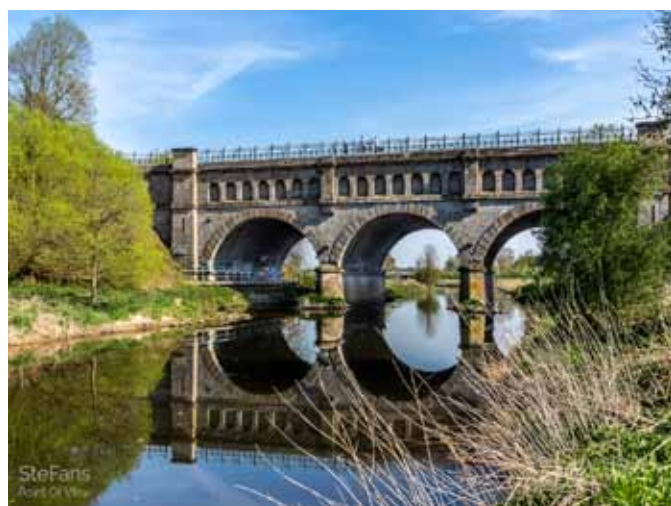
Dreibogenbrücke über der Stever in Olfen
