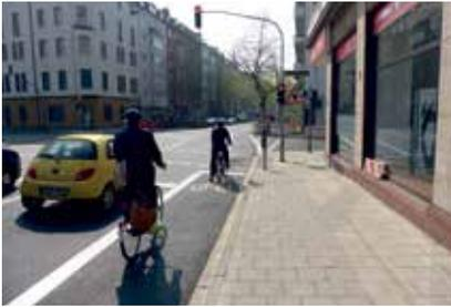
*Worringer Straße: Im Rahmen der Sanierung der Fahrbahndecke wurden die einzelnen Fahrstreifen neu angeordnet und eine gesicherte Radwegführung markiert. © Landeshauptstadt Düsseldorf, Amt für Verkehrsmanagement*
