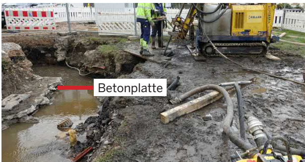
Bild 9.4 – Bohrarbeiten und angetroffene Betonplatte
