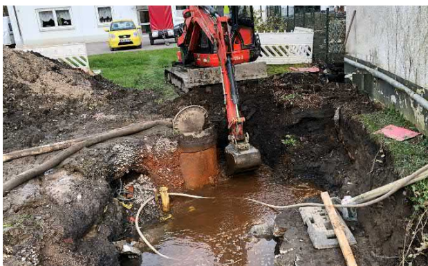
Bild 9.2 – Schurf mit freigelegtem Drainageschacht und Wasserzufluss
