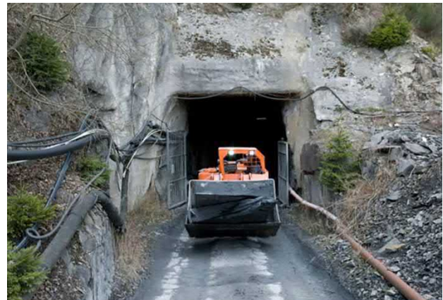
Bild 8.1 – Stollenportal des Verbundbergwerks Gomer (Quelle: MAGOG GmbH & Co. KG)
