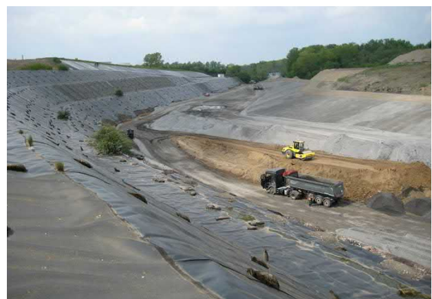
Bild 3.2 – Abfalleinbau am Deponiestandort Vereinigte Ville, Tonbandeinschnitt (Quelle: Dr.-Ing. Asenbaum)
