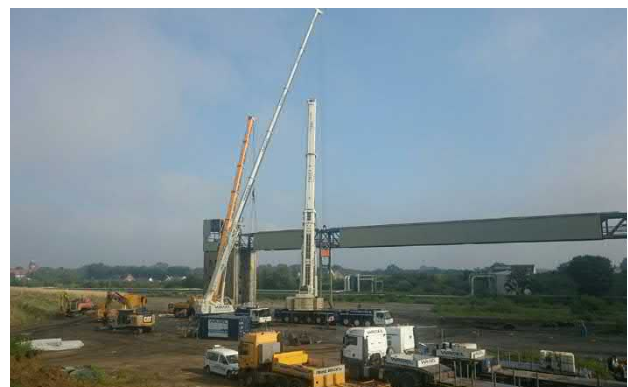
Bild 11.5 – Rückbau der Bandbrücken (Quelle: Bezirksregierung Arnsberg)
