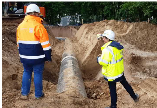
Bild 13.2 – Befahrung der Aufsichtsbehörde bei der Rohrverlegung (Quelle: Bezirksregierung Arnsberg)
