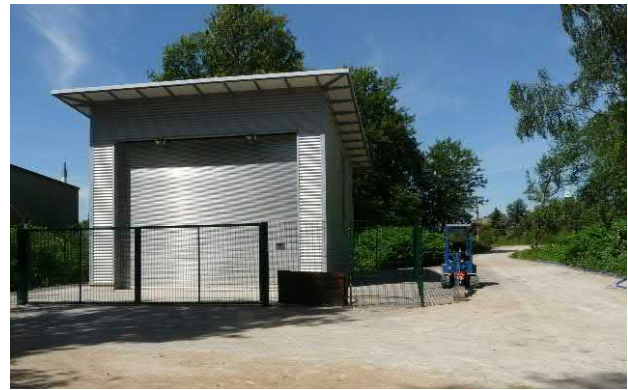
Bild 11.6 – Grundwasserreinigungsanlage und ehem. Gleisstrasse (Quelle: Bezirksregierung Arnsberg)
