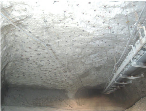
Bild 7.7 – Streckenkreuz 101 nach Durchführung der Sanierung
