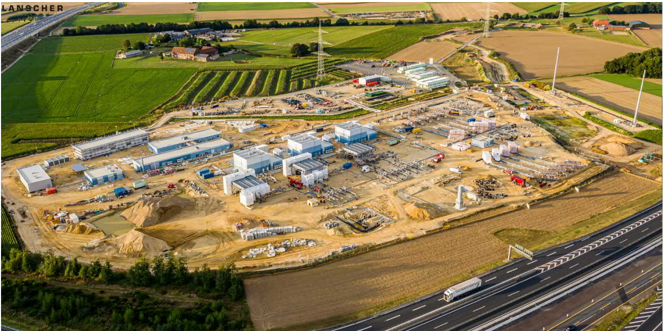
Bild 13.3 – Verdichterstation Würselen im Bau, 2020; etwa mittig die 3 Hallen mit den Turboverdichtereinheiten (Quelle: Open Grid Europe GmbH)
