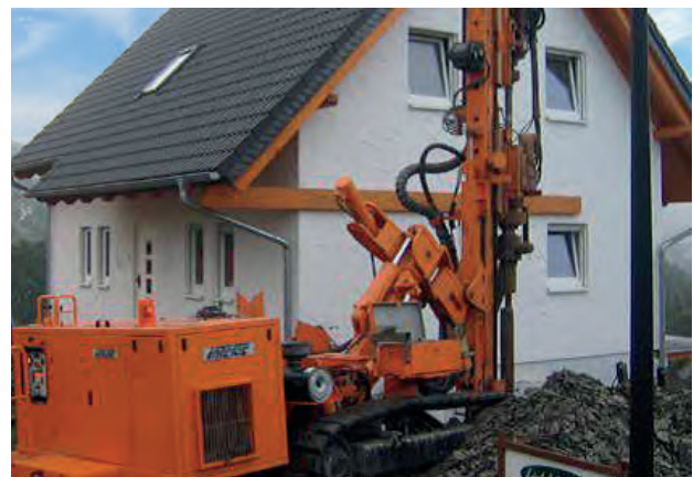
Bild 2.2 – Geothermiebohrung (Quelle: H. Spiekermann Bohrtechnik GmbH)
