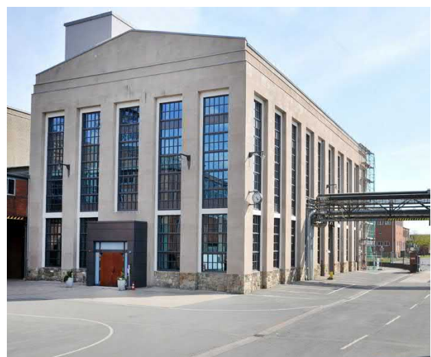
Bild 5.2 – Umgebautes altes Betriebsmittellager zur neuen Verwaltung "Standortquartier" (Quelle: RAG Anthrazit Ibbenbüren GmbH)
