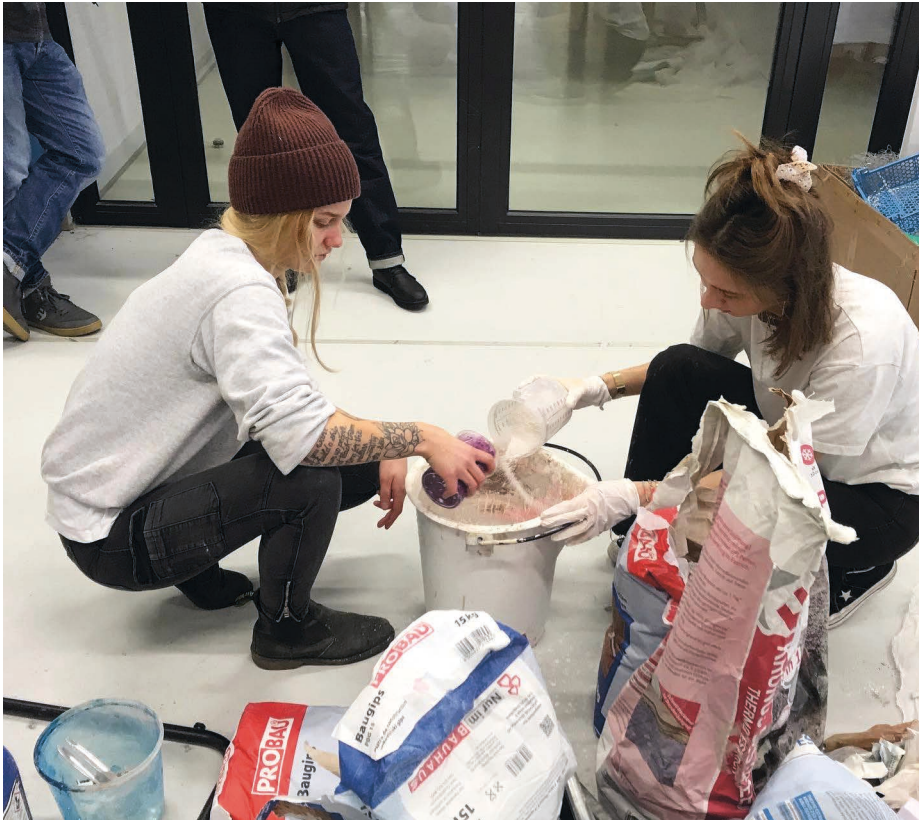
Im Prozess – Bau und Herstellung des Messestandes
