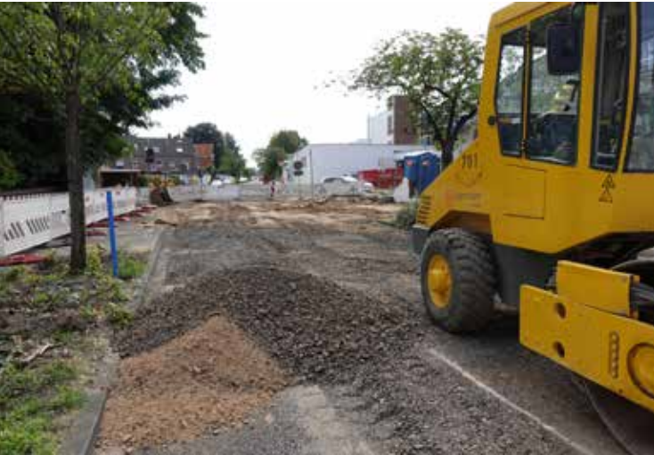
Die Baumaßnahme eines Staukanals an der Poststraße hat bereits im August begonnen. Foto: Andreas Voss
