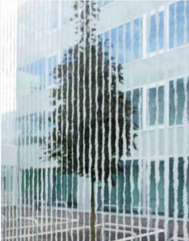
Ein Blick durch die exklusive Fassadenverglasung des Campus Hoogvliet in Rotterdam: Das Glasdekor mit abstrahierten Efeuranken entstand durch mehrfache Bearbeitung: das in Gussglas eingeprägte Motiv wurde im Nachgang mit unterschiedlichen Techniken bedruckt. Dadurch entstand ein dezentes, aber außergewöhnlich wirkendes Glas.
