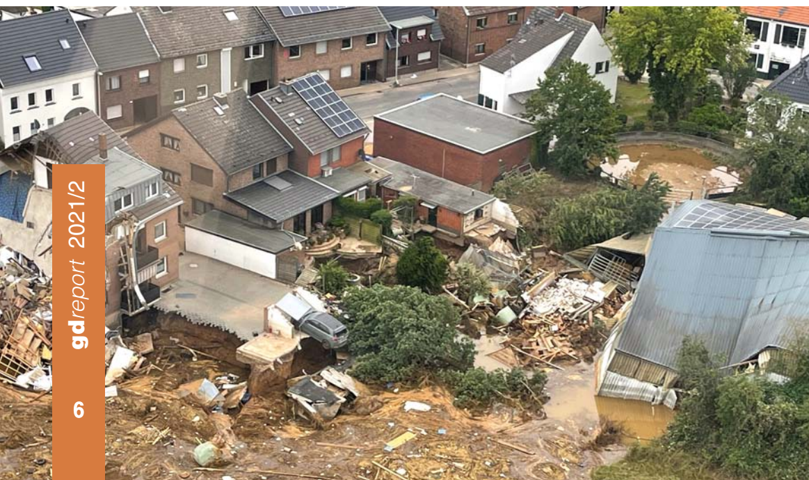
Überblick über den überfluteten Schadensbereich in Blessem (18. Juli)
