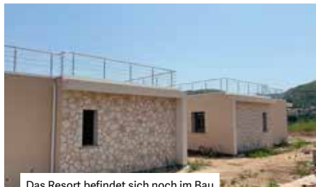
Das Resort befindet sich noch im Bau
