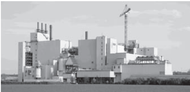
Die Krefelder Müll- und Klärschlammverbrennungsanlage wird erweitert.
