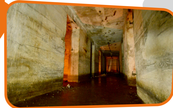
Innenaufnahme des ehemaligen Luftschutzbunkers am Zonser Feldtor (Foto: Jörn Esposito)
